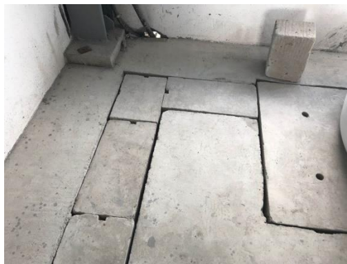
库内废液收集池
